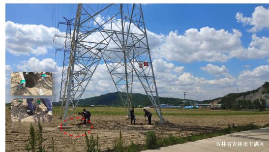
图 7 腐蚀实验实地取样、埋片图
